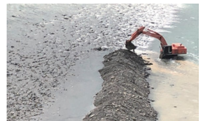
流路に入って瀬回しを下流側から行っているため、ダダ濁り
