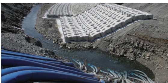
涙が出るほど立派な集水路。作業面は完璧にドライ 富士川本流 施工：(株)望月組土木
