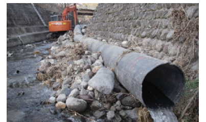
仮設パイプで作業場所の水を切り回そうとしている
