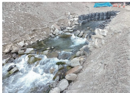
日川における付け替え水路の状況
